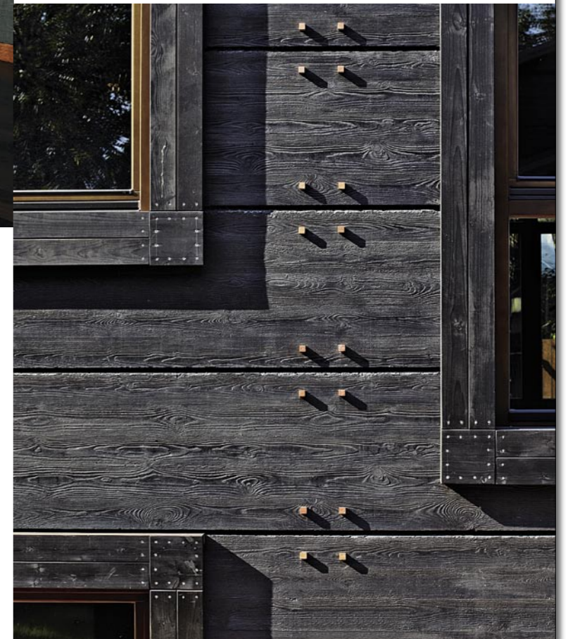
Ein mit rotem Mosaik belegter Block verbindet die Geschosse, die ohne Innenwände auskommen. Beim Entwurf orientierte sich Juri Konik (rechts oben in seinem Büro) an Vorbildern wie Malewitsch und Melnikow. Re.: Jedes Bohrloch im Beton bekam eine Abdeckkappe. Architektenkontakt im AD Plus.
