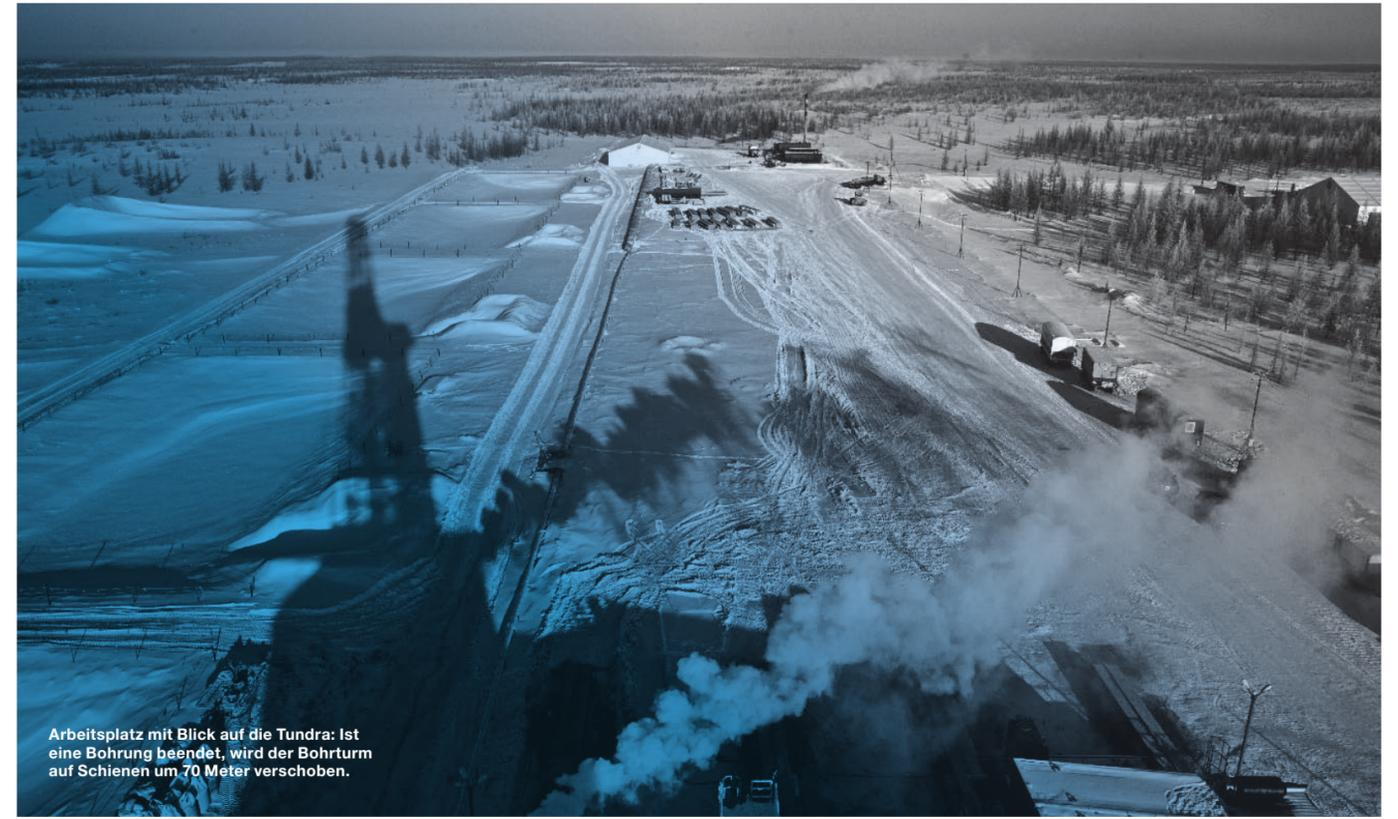
Arbeitsplatz mit Blick auf die Tundra: Ist eine Bohrung beendet, wird der Bohrturm auf Schienen um 70 Meter verschoben.
